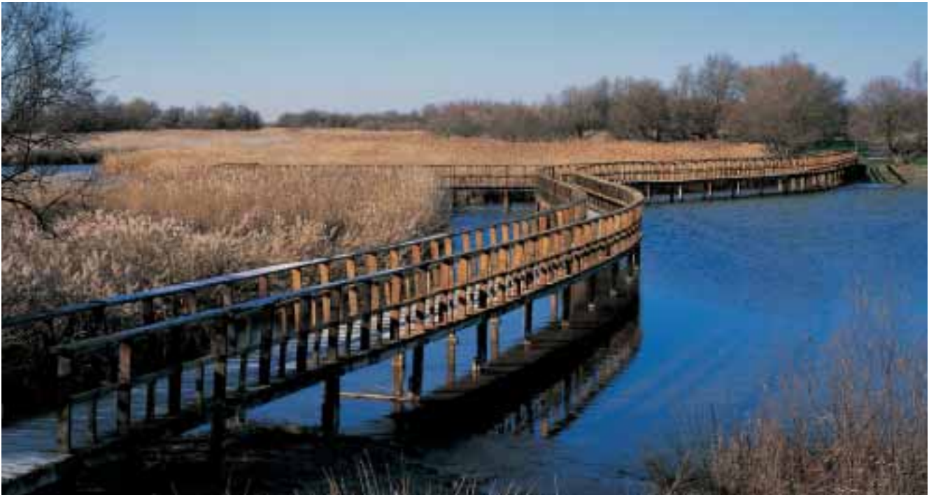
Pasarelas del itinerario de la Isla del Pan
